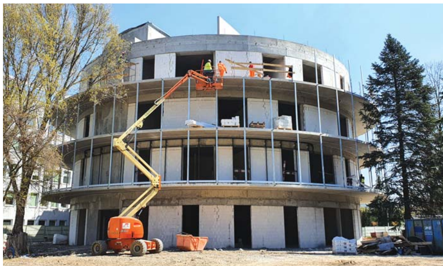
Budowa „Budzika” dla dorosłych na Bródnie
